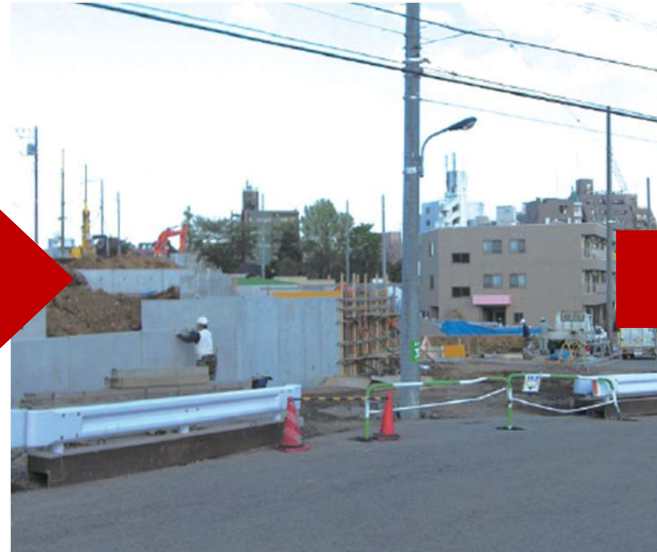
着々と工事が進む
