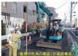
重機の死角の確認(交通誘導員)
