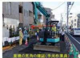
重機の死角の確認(手元作業員)
