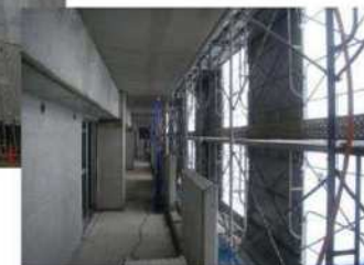
(自然光の取入れ状況)
