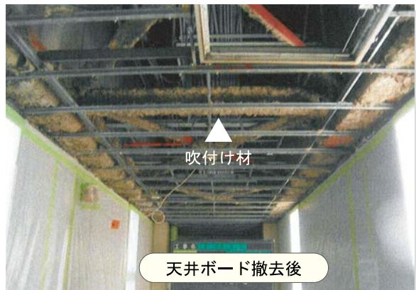
配管・配線スペースを兼ねている廊下天井裏の梁や柱に、青石綿・茶石綿含有の厚さ30mmの吹付け材が使用されていたため、除去することになった事例です。狭い空間内で行う、配管等の養生やアスベストの除去は作業効率が低く、時間を要します。除去工事にかかる工期や費用は作業環境によっても大きく異なりますから注意が必要です。
