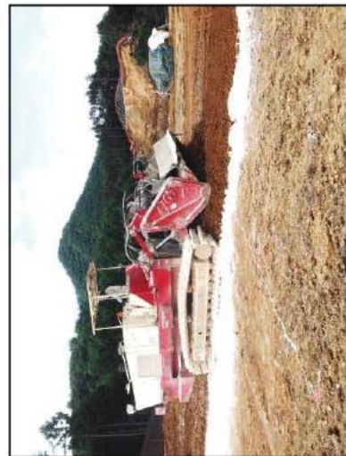
軟弱土に生石灰を混合し土質を改良 (スタビライザを用いた固化剤(生石灰)の混合状況)
