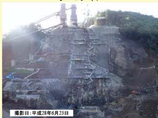
本体工事(基礎掘削(左岸))
