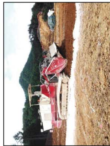
軟弱土に生石灰を混合し土質を改良 (スタビライザを用いた固化剤(生石灰)の混合状況)
