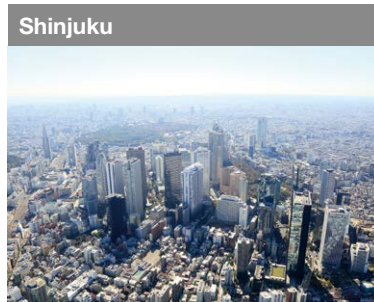
Shinjuku Medio siglo después del desarrollo de la antigua planta purificadora de agua de Yodobashi, este centro de negocios está entrando en el período de renovación.
