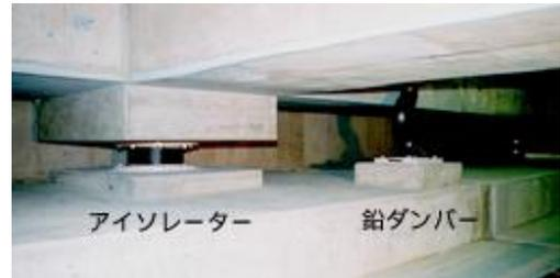
①礼拝堂地下に設置の免震装置
