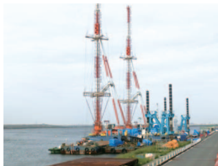
ドレーン打設船
