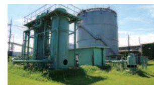
脱硫装置 (左)、ガスホルダ (右)
