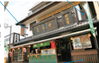
エアコン室外機：目立たないように修景
