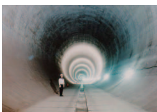
トンネル内部
