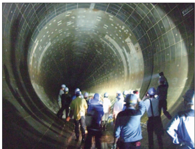
和田弥生幹線 (工事完成見学会の様子)
