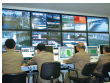
監視状況 (水防活動時)
