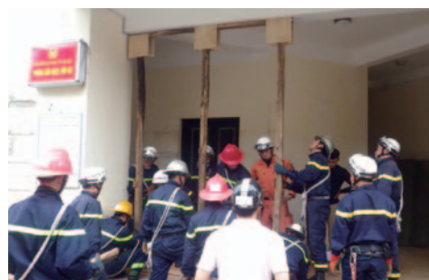
ショアリング（倒壊建物等の安定化技術）指導
