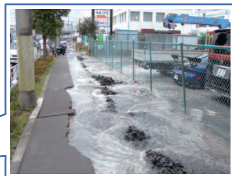
東日本大震災（2011年3月11日）に低地で発生した液状化現象 ※道路の割れ目から、砂と地下水が噴き出している。
