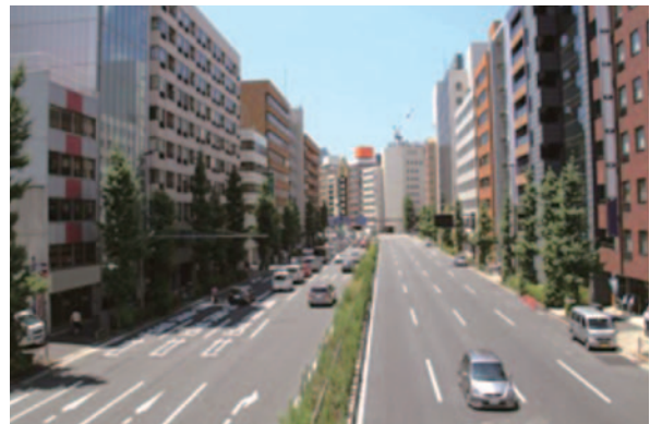
災害時に緊急物資の輸送などの大動脈となる緊急輸送道路
