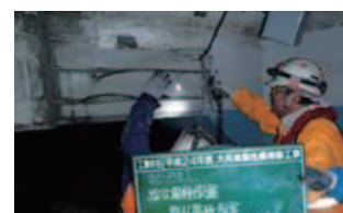
電気防食工法による補修
