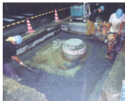
発見された空洞の復旧
