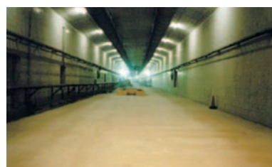
沈設後の 函体内部
