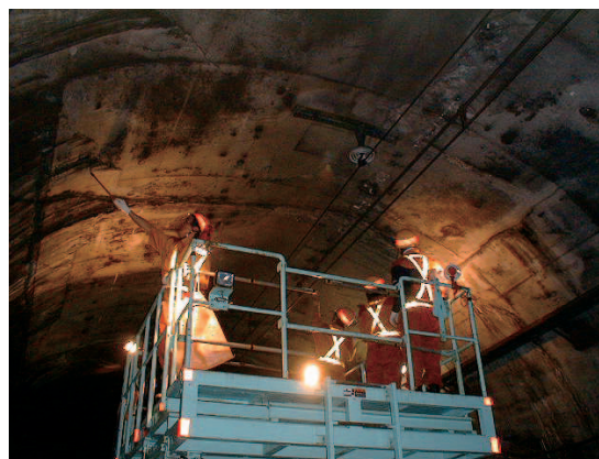
トンネル内の打音調査状況
