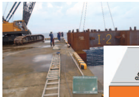
鋼枠据付状況
