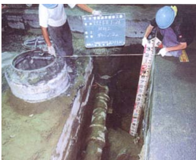
レーダーで発見された空洞の開削調査
