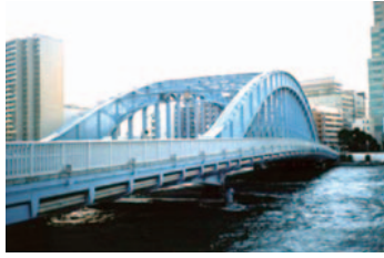
永代橋 (1926 年完成)
