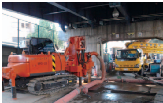
増し杭の打設
