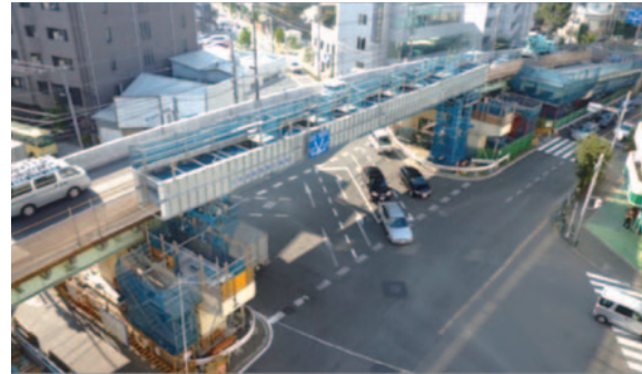
上部工（桁）の取替
