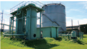
脱硫装置 (左)、ガスホルダ (右)
