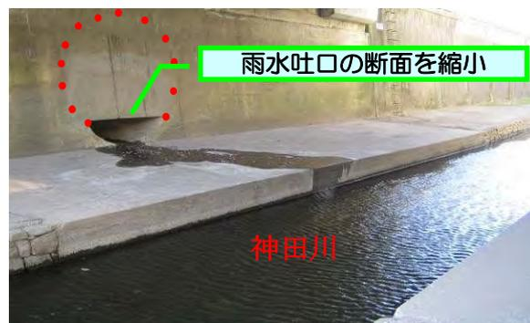
写真 4-4 下水道から河川への放流量規制の例
