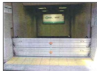
写真 4-7 止水板による地下浸水対策の例
