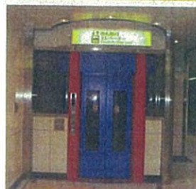
窓なしエレベーターの改修
