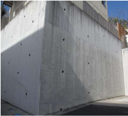
鉄筋コンクリート造擁壁
