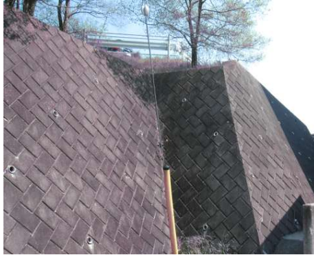
間知ブロック積擁壁
