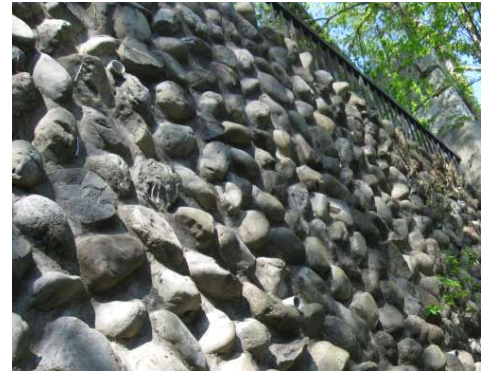
玉石積み（石積み）擁壁
