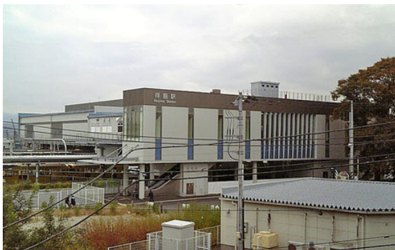
拝島駅橋上駅舎
