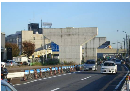
国道16号（南町田駅付近）
