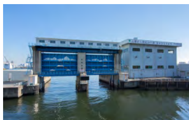
水門・排水機場
