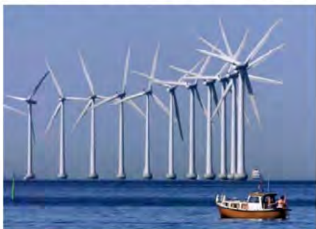
エネルギー供給施設 岩手県HP
