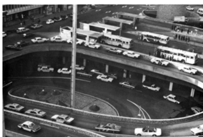
▲新宿駅西口駅前広場（地上） 【出典】新宿副都心建設事業のあらし（新宿区都市整備部）
