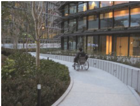
スロープによる段差解消
