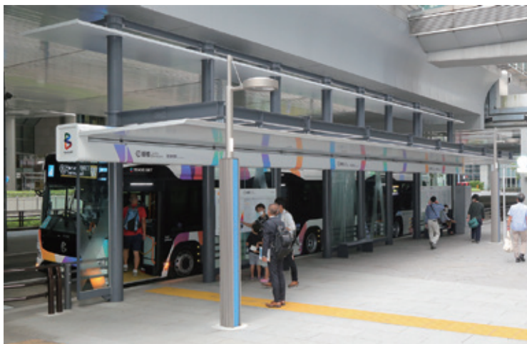
東京BRT新橋停留施設と連節車両
