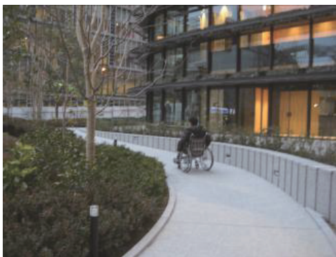
スロープによる段差解消
