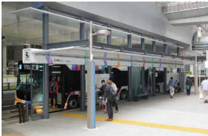
東京BRT新橋停留施設と連節車両
