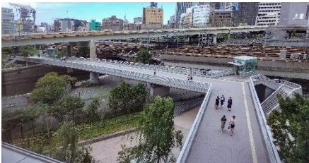
事例：竜閑さくら橋 (千代田区・中央区) ※公共施設
