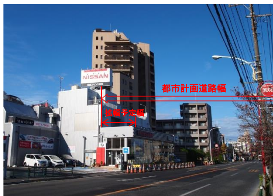
〔建築制限により高さ制限と除却可能な建築となっている事例〕
