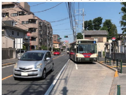
図 3-9 バス停留所（バスベイ）の設置例
