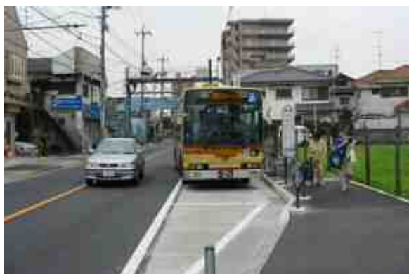
図 3-9 バス停留所（バスベイ）の設置例
