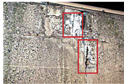
◀ 擁壁の損傷状況 (コンクリート剥離・鉄筋腐食)
