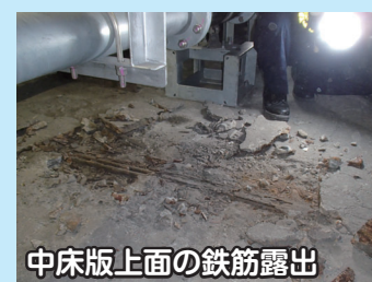
中床版上面の断面欠損
