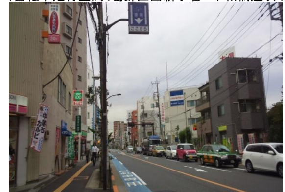
<自転車走行空間(葛飾区西新小岩 平和橋通り)>
