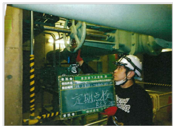
写真3-5 雨水貯留施設等の点検
