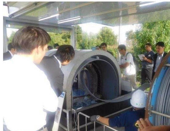
管きょ更生工法講習会
