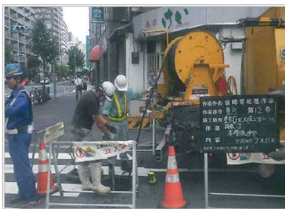
写真3-4 故障処理作業（詰まり解消）
