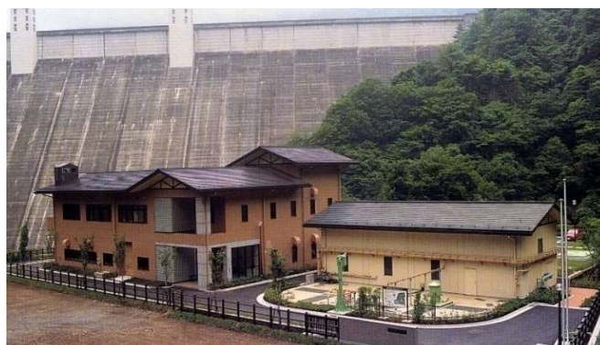
写真 4-3-2 奥多摩町小河内浄化センター
