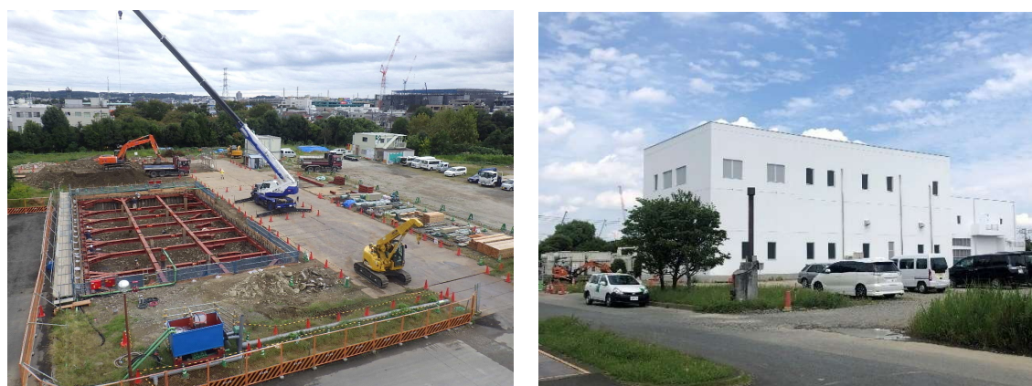
図 4-3-4 立川市錦町処理区編入に伴い新設中の北多摩二号水再生センターポンプ棟
