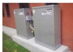
無停電設備（蓄電池・移動用発電機）
