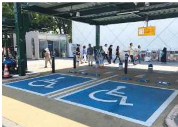
障害者等用駐車区画へ屋根を設置した例
