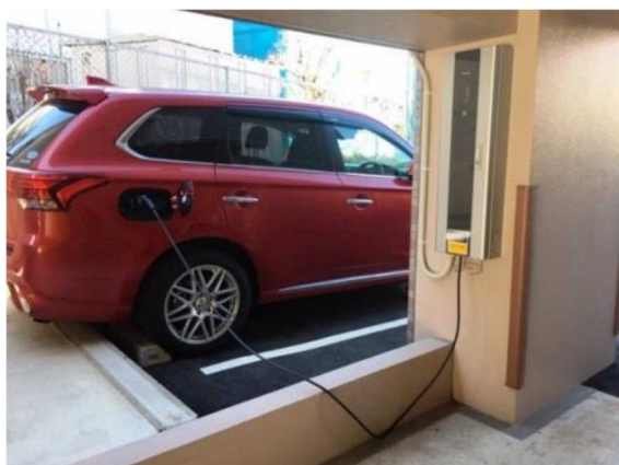
図 2-53 集合住宅における充電設備設置例
