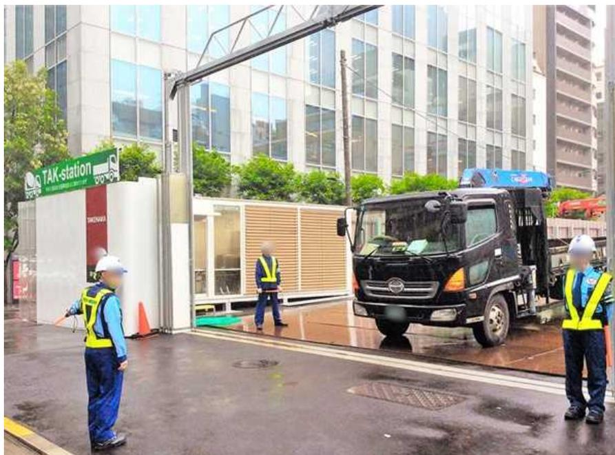
図 3-15 工事関係車両が一時的に待機できる駐車ヤードを確保した例
