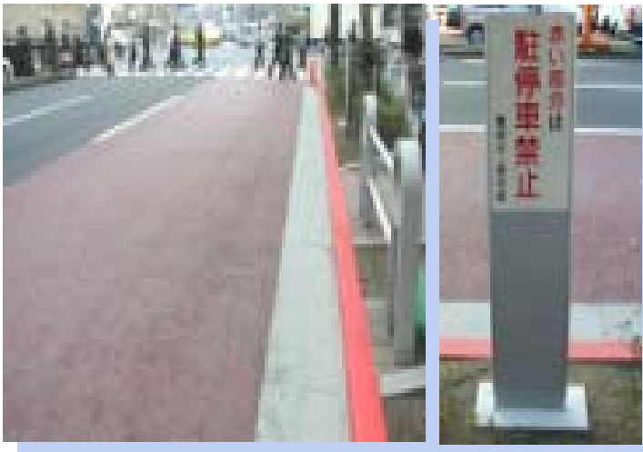
< 赤系カラー舗装による駐停車禁止区間の明示 >
