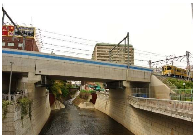
図 4-10 河川整備（神田川）と連携した鉄道橋の架け替え（新宿区）
