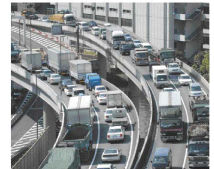
首都高速都心環状線（神田橋）の状況 [出典:国土交通省資料]
