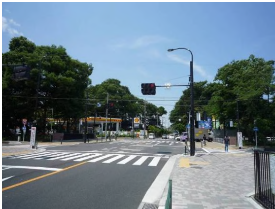
小金井街道小金井橋交差点（小金井市桜町）
