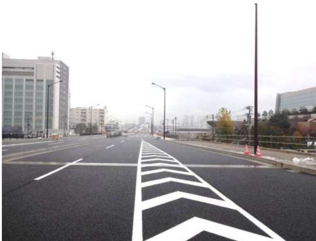
写真：建設中の環状2号線（晴海付近）
