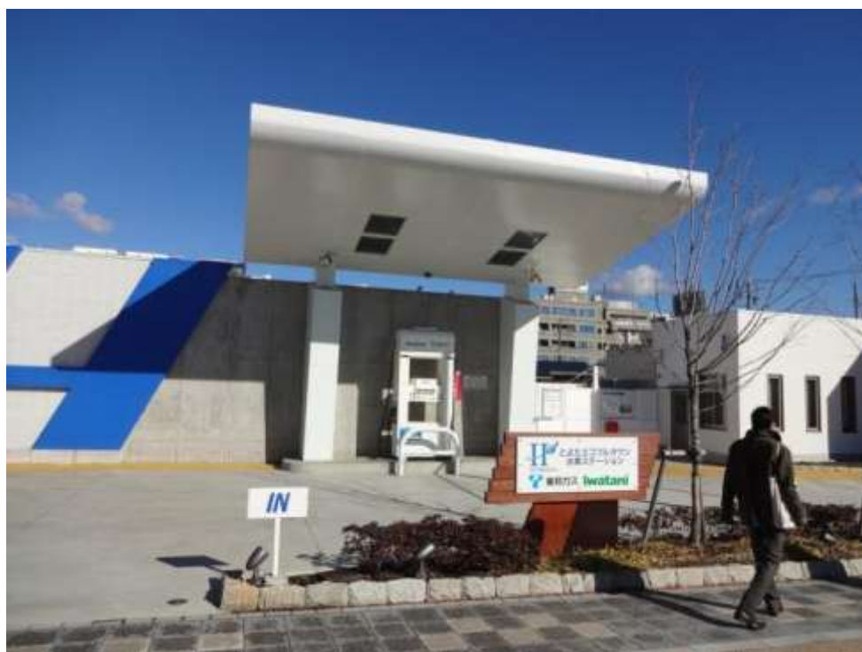
写真：水素ステーション（豊田エコフルタウン）
