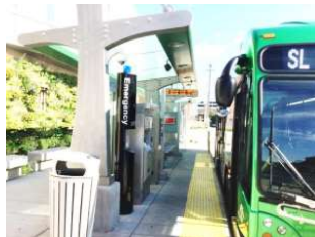
上屋を設けた停留施設の例
