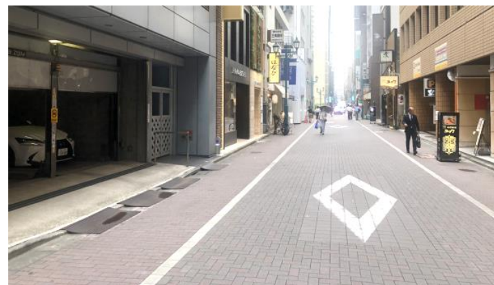
駐車場出入口による賑わいの連続性が分断される例
