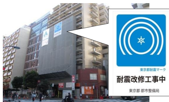
写真 耐震改修工事現場における耐震マークの掲示 (左) 掲示風景 (右) 拡大図
