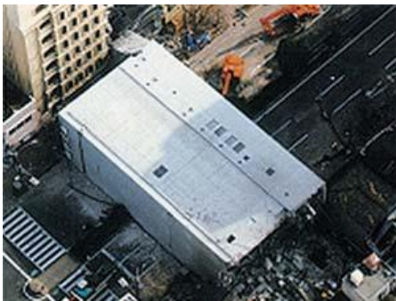
写真 阪神・淡路大震災における建築物倒壊による道路閉塞の様子 (出典：(左)神戸新聞社，(右)一般財団法人 消防科学総合センター)
