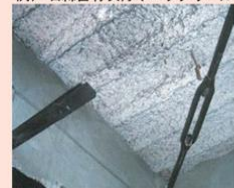
例) 石綿含有吹付けロックウール
