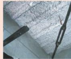
例) 石綿含有吹付けロックウール
