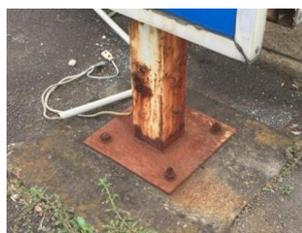
支柱、ベースプレート、アンカー共にさびが顕著な状態
