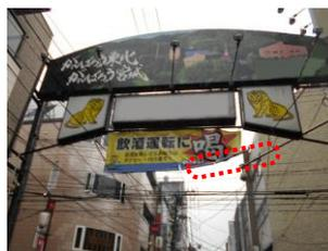
幕材を張る部材が破損した
