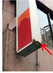
広告板底部の腐食が進行した状態
