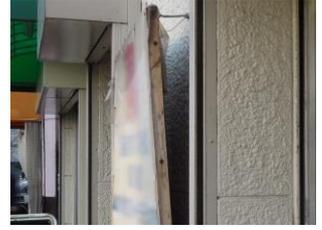
壁面との間に隙間が生じた状態
