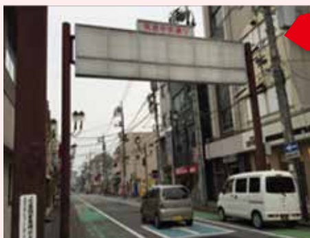
撤去されずに残されたアーチ看板
