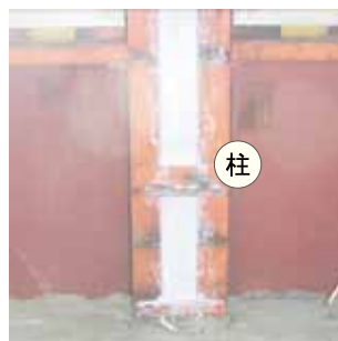
柱の耐火被覆材の封じ込め
