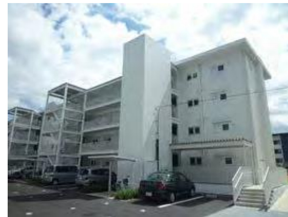
（既存の階段室を撤去しエレベーターを新設）
