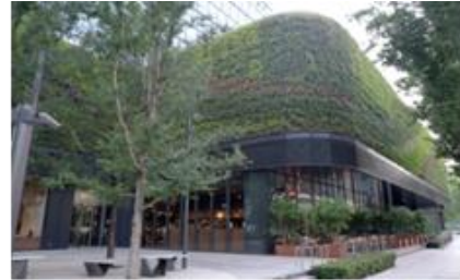
豊洲フォレシア（パネル型ユニットにより敷地面積に対し約44%の緑化率）
